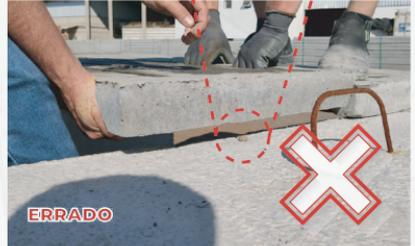
Local de apoio do Piso CS com pedra causando irregularidade.
