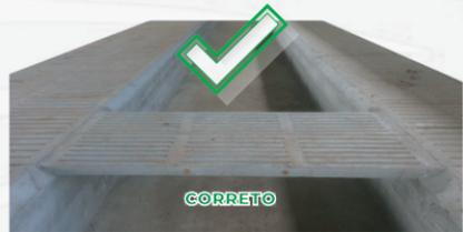
Sempre antes de iniciar a montagem, nivelar e aprumar as vigas que servirão de apoio para as grades, a base de apoio deve ter superfície plana e limpa para que as grades fiquem bem niveladas e firmes, dispostas uma ao lado da outra;
